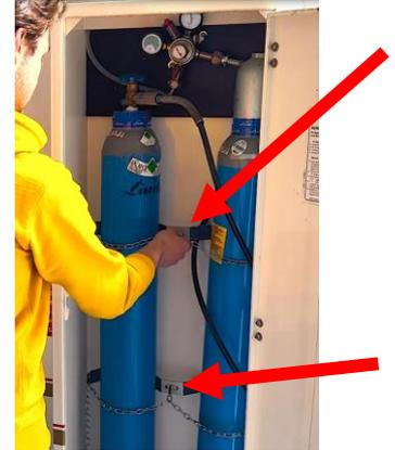
Türe des Kastens öffnen und kontrollieren, dass beide Kartuschen angekettet sind.
